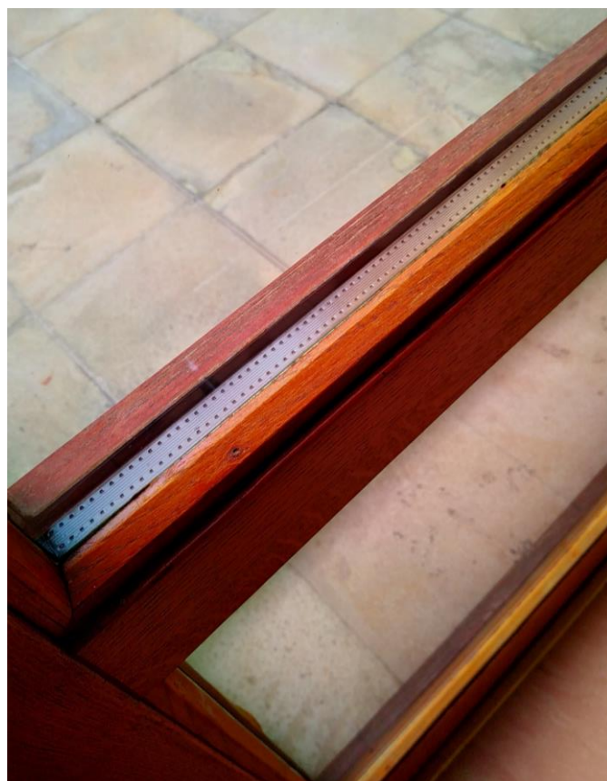
Obr. 7.: Detail okna s dvojsklem do atria
